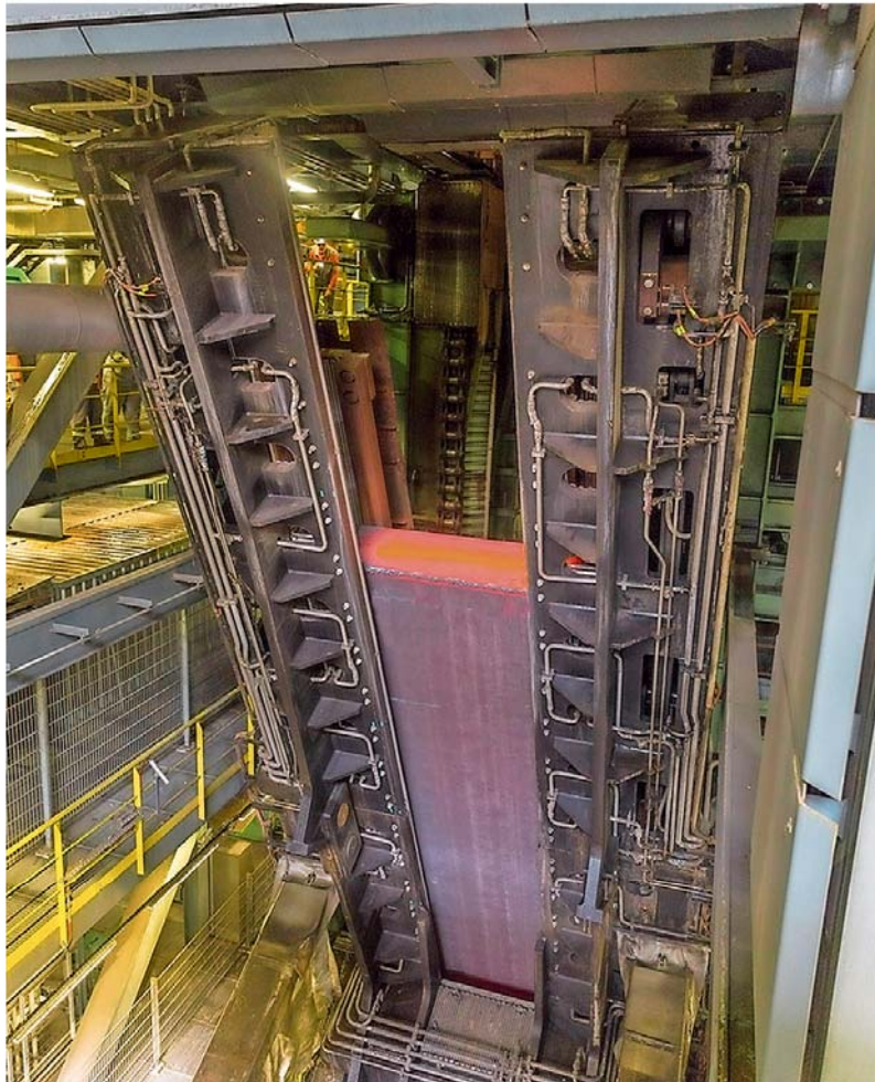
Die Dillinger Hütte kann in der neuen Anlage Brammen in der Produktion durchgehend senkrecht gießen.
